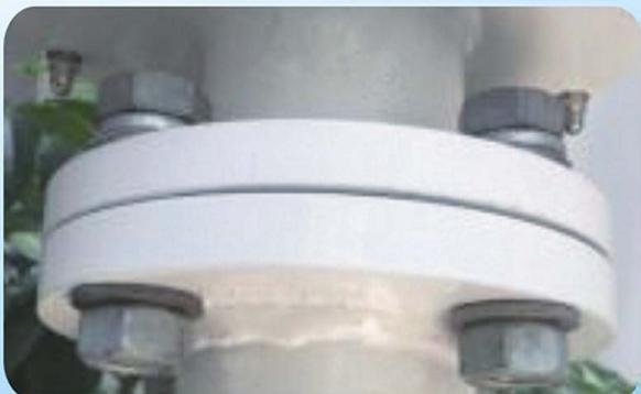
7. Instale el aerogenerador haciendo coincidir la brida del aero con la brida de la torre; utilice los accesorios provistos tuercas/arandelas y apriete las tuercas firmemente.
